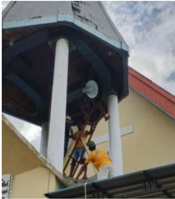
Gambar 3. Proses pemasangan horn speaker pada menara gereja
